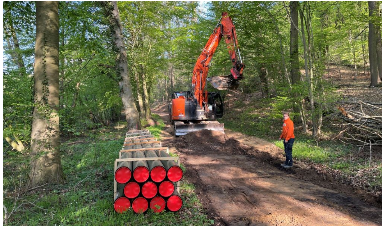
Die neue Leitung wird im Wald unter dem Radweg gebaut.
