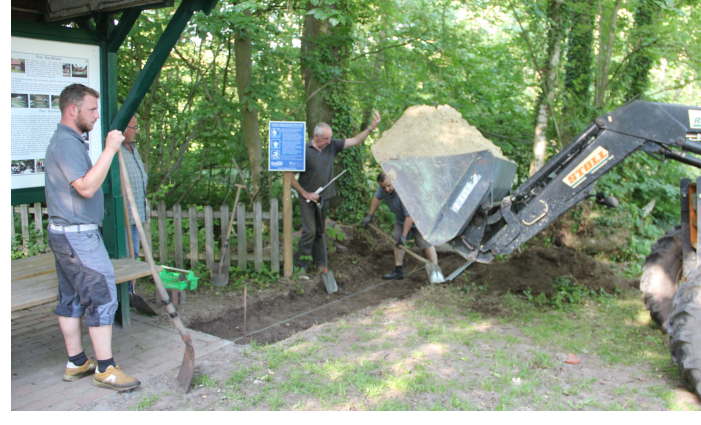
Am Montagabend pflasterten die Helfer den Weg von der Treppe in den Bach bis zu den Ruhebänken an der Infotafel.
