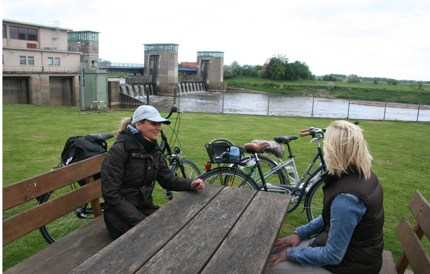
Das Wehr mit Laufwasserkraftwerk in Drakenburg liegt an der „Energie-Entdeckeroute Mittelweser“.
